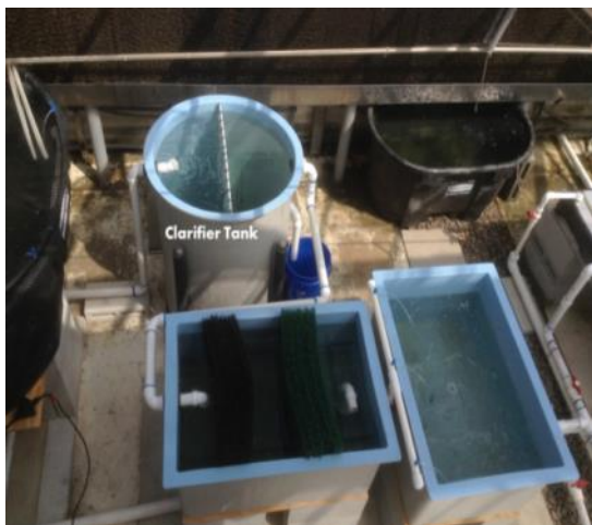
Figura 7. Dos tanques clarificadores conectados en serie. El primero depende de la gravedad para separar los sólidos, el Segundo depende en unas
